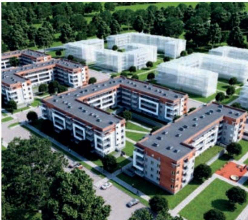
Kombinat Budowlany Sp. z o. o. - Nowa Wygoda - kompleks kameralnych budynków wielorodzinnych, ul. 42 Pułku Piechoty, Białystok.
