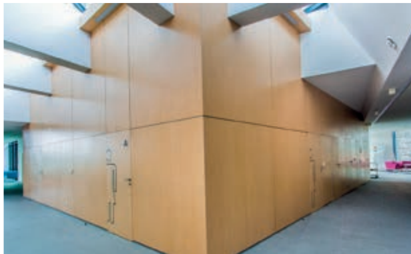
Firma W.AWRUK Stolarka Budowlana - Ośrodek Sportu i Rekreacji w Olsztynie zabudowa ścienna w okleinie naturalnej.
