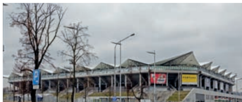
MAR-BUD Budownictwo Sp. z o. o. - Stadion Legii przy ul. Łazienkowskiej w Warszawie.
