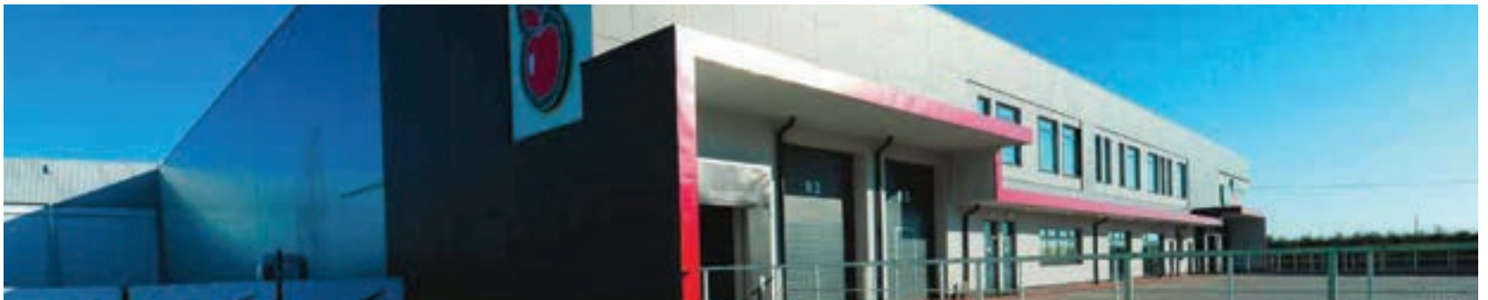
BUDREM Group Sp. z o. o. - Sortownia owoców z zapleczem sanitarno-higienicznym i biurowym w Białej Rawskiej.
